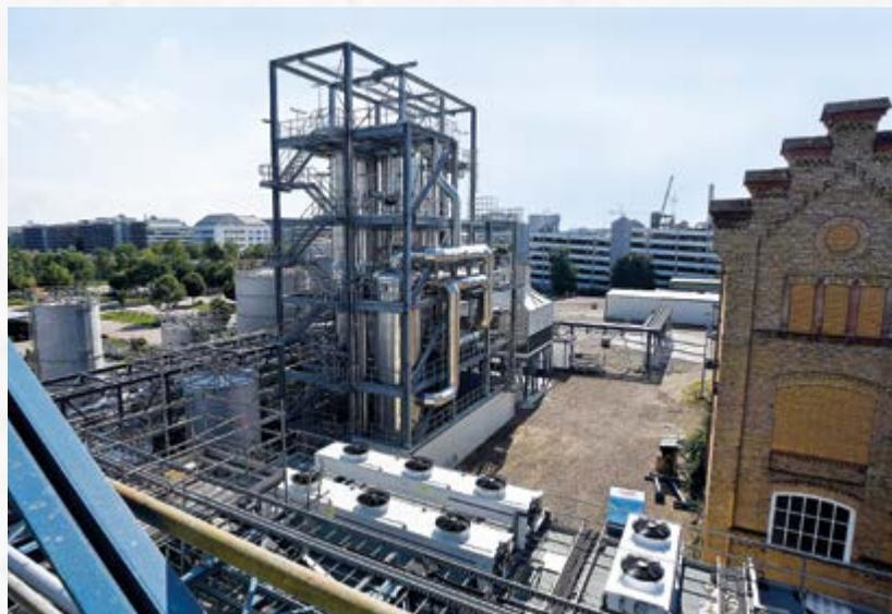
**Neues neben Altem:** Die Mannheimer Strohzellstoff-Fabrik erforderte umfangreiche Neubauten, teils direkt neben den alten Gebäuden. Links im Bild die Eindampfanlage für das weiterverwendbare Nebenprodukt Lignin. Die Anlage ist 30 Meter lang, 16 Meter breit und 34 Meter hoch.
