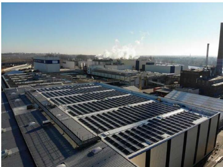
*Die Photovoltaik-Anlage auf dem Essity-Dach hat eine Leistung von 380 kWp und wird so viel Strom produzieren, wie ihn etwa 85 Vierpersonenhaushalte verbrauchen. So hilft sie pro Jahr gut 250 Tonnen CO<sub>2</sub> einzusparen.*
