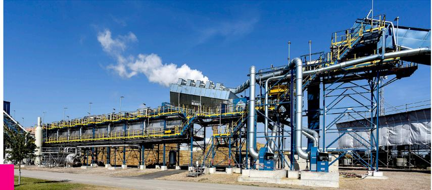
Zur Anlage gehört auch ein neues 10.000 Quadratmeter großes **Strohlager**. Von dort transportieren Stapler die bis zu 650 Kilogramm schweren Strohballen auf ein **Förderband**, das direkt in die Fabrik führt. Auf dem Weg dorthin wird das Stroh in mehreren Schritten sortiert und gereinigt.
